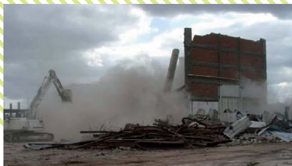
Bâtiments 7 et 8 en cours de démolition
