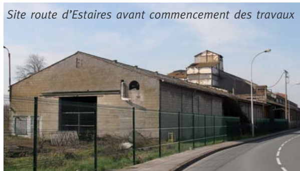
Dépose des tôles du bâtiment 4
