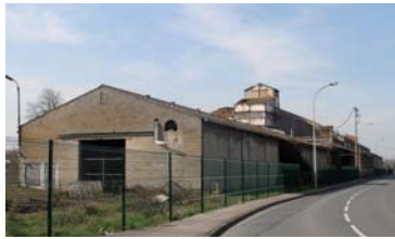
Site avant travaux depuis la route d'Estaires
