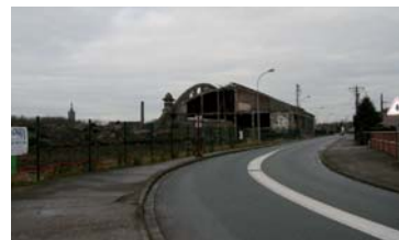
Décembre : Site avant la démolition finale
