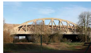
Arche avant démolition vue depuis les Près de la Ville
