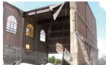
Septembre : Bâtiment 7 avant démolition
