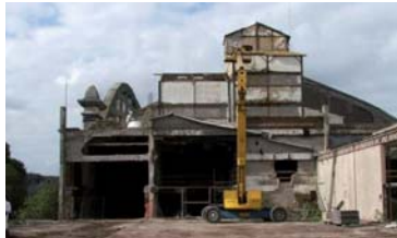
Septembre : Dépose des tôles du bâtiment 2
