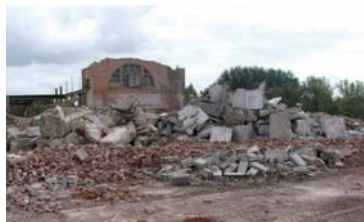
Septembre : Bât. 5.6.7.8, murs d'enceintes abattus
