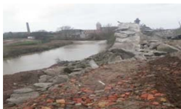
Janvier : Démolition finale du site
