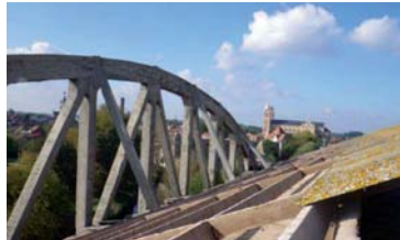
Octobre : Dépose toiture bât.2 côté ouest
