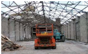
Septembre : Dépose des tôles du bâtiment 4
