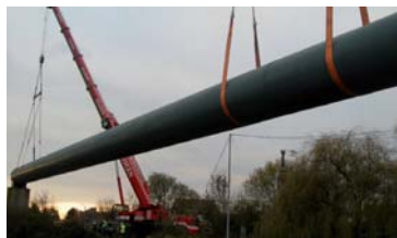
Novembre : Dépose du convoyeur
