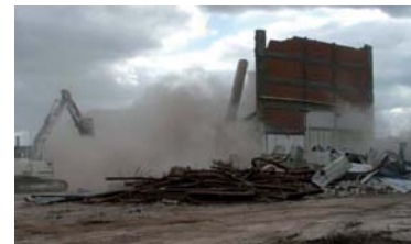
Septembre : Bâtiments 7 et 8 en cours de démolition
