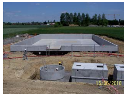
Construction du bassin de rétention de la zone d'activités du Bois à Fleurbaix
