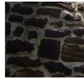
Le **grès ferrugineux**, est une roche solide exclusivement présente au niveau des Monts de Flandre. Il est donc normal de retrouver ce matériau dans les constructions. Par exemple, à Cassel, le grès est visible au niveau de la porte des remparts.
