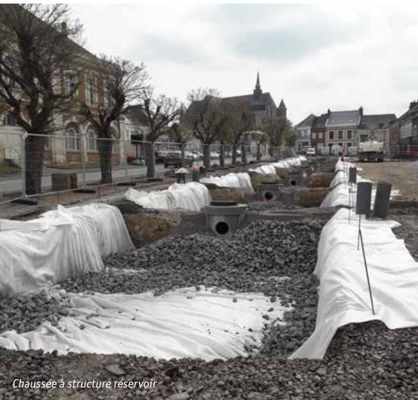
Chaussée à structure réservoir
